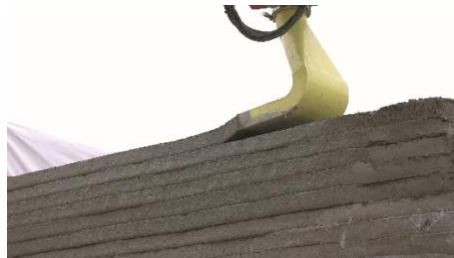
Bildbeschreibung: Karlos trägt anhand eines vordefinierten und digitalen Bauplans über einen speziellen Druckkopf Beton exakt in mehreren Schichten auf.
